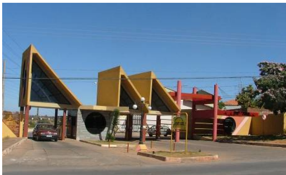
Figura 136 - Entrada do Condomínio Jardim Europa, no Setor Grande Colorado.
