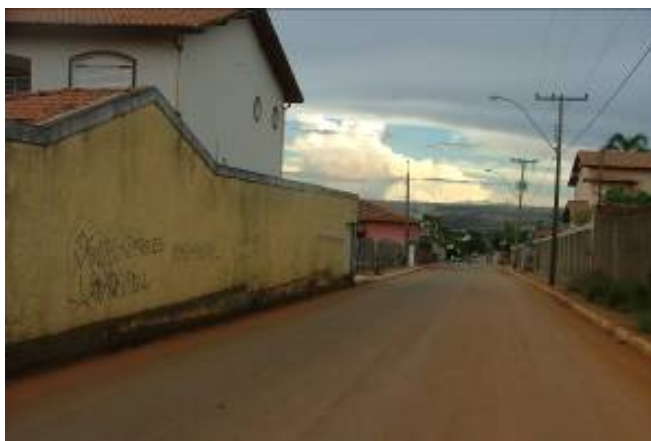
Figura 166 - Rua no Setor de Mansões Sobradinho, onde a calçada foi suprimida.
