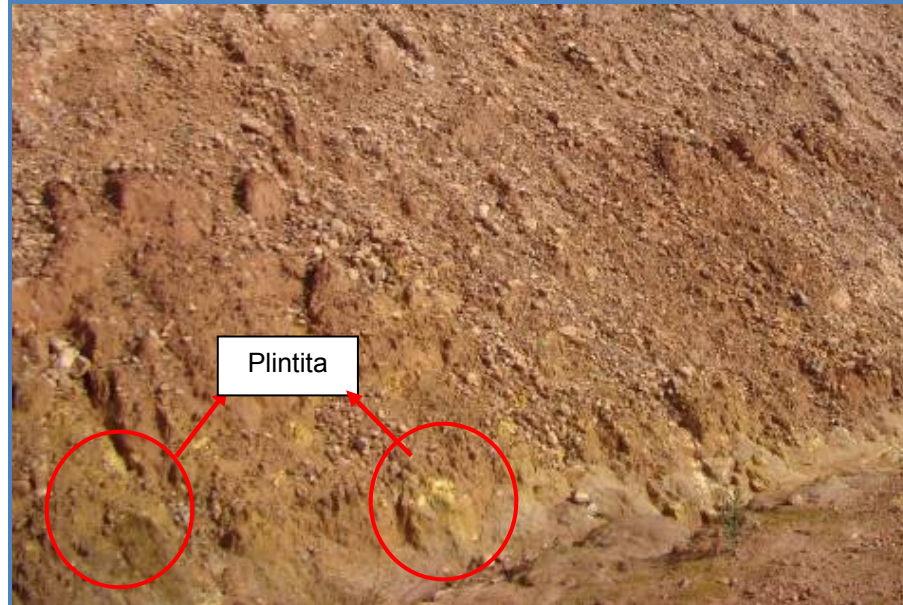
Figura 31 - Aspecto do plintossolo identificado no local.
