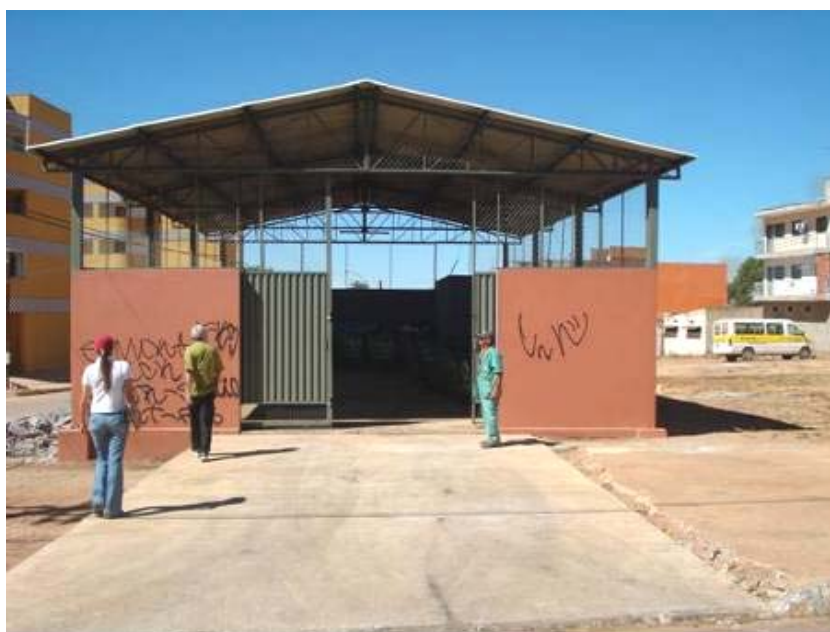
Figura 198 – Galpão para separação de Resíduos em Coleta Seletiva
