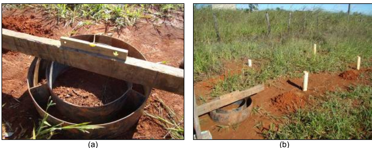
Figura 36 – (a) Ensaio de permeabilidade superficial no ponto 02 e (b) praça de ensaio de infiltração no ponto 02.
