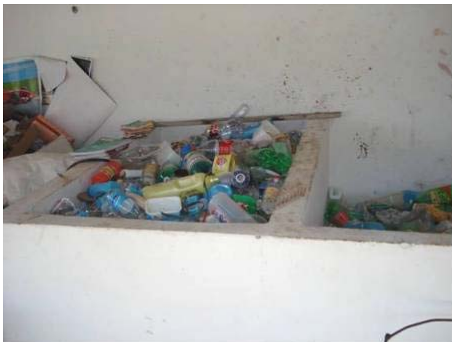
Figura 199 – Baias para separação de Resíduos Secos
