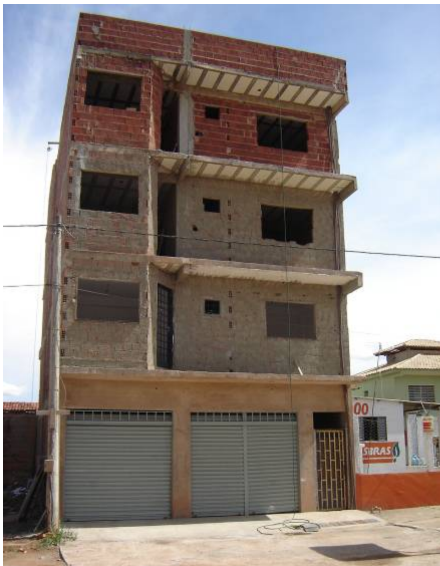
Figura 104 – Prédio em construção na Avenida São Francisco
