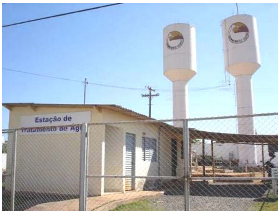
Figura 192 – Área Cercada com Reservatório e Estação de Tratamento de Água
