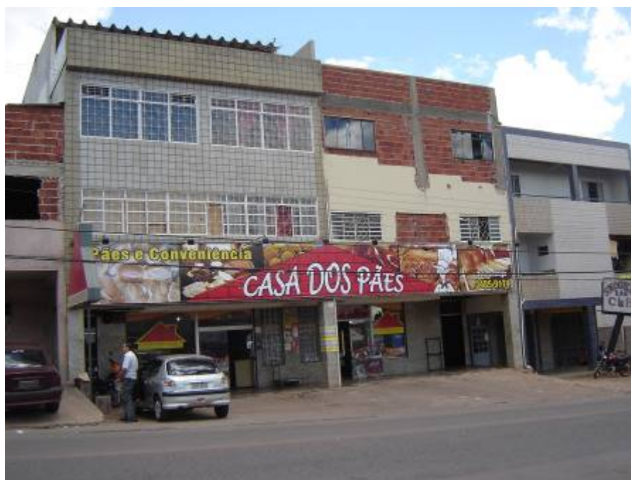
Figura 103 – Edificação na Avenida São Francisco.
