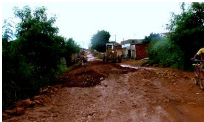
Figura 159 - Trecho do Setor Contagem, em que as condições urbanas são mais precárias. Na foto, a rua que atravessa o Parque Canela de Ema, durante a época das chuvas.
