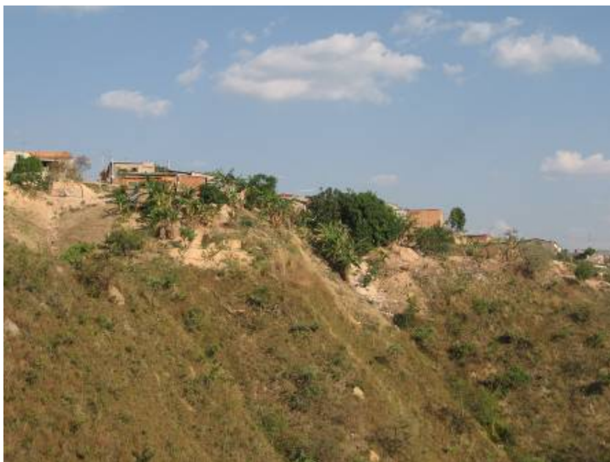
Figura 178 – Edificações próximas aos limites das encostas.
