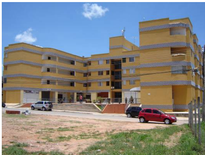
Figura 35 – Padrão construtivo no condomínio Solar de Athenas
