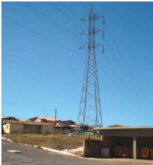
Figura 53 – Torre de Linha de Transmissão de Energia Elétrica.
